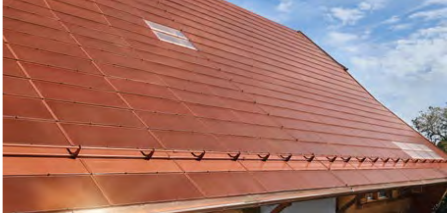
Le dépôt d'un nano-film blanc ou coloré pour recouvrir des modules solaires élargit considérablement les possibilités et le confort d'intégration du photovoltaïque.
