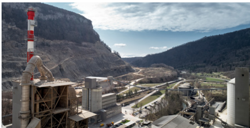
Am Standort Péry-Reuchenette (BE) wurden die CO 2 -Emissionen seit 1990 um 34 Prozent reduziert. Bis 2021 sollen es 40 Prozent werden.
