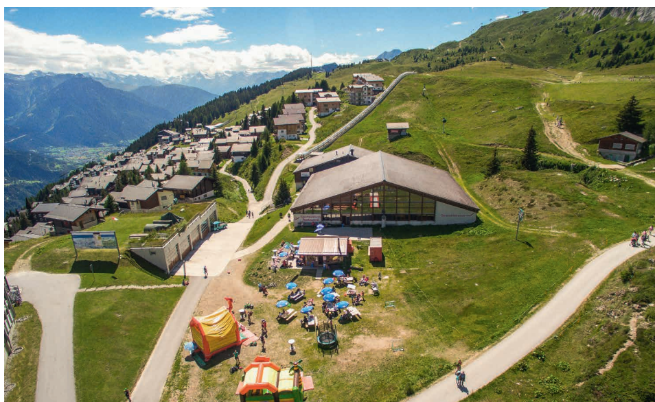
Der exponierte Standort an der Sonne macht sich auch im Energie-Management des Sportzentrums Bachtla bemerkbar.
