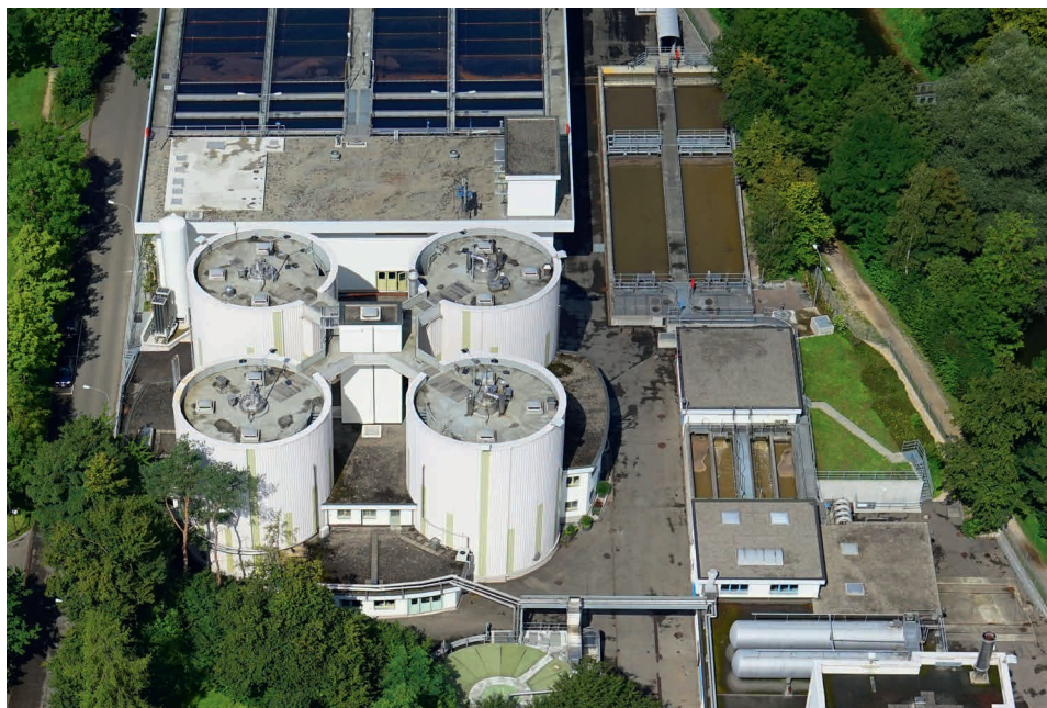
La STEP de Neugut (ZH) épure les eaux usées communales depuis 1964. Depuis qu'elle collabore avec l'AEnEC, sa performance énergétique s'est encore améliorée.
