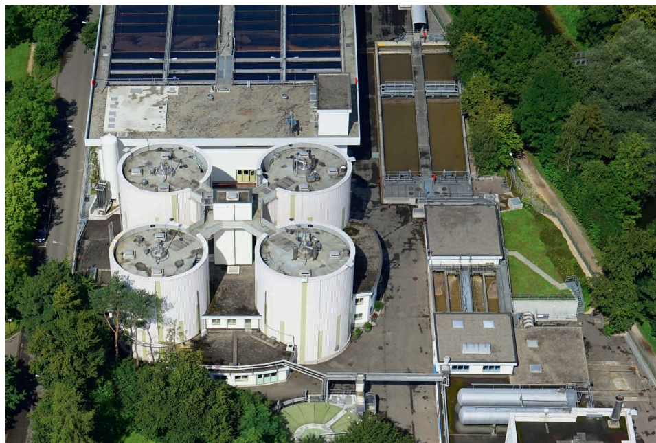
Die ARA Neugut reinigt seit 1964 kommunales Abwasser. Seit der Zusammenarbeit mit der EnAW tut sie dies energieeffizienter denn je.
