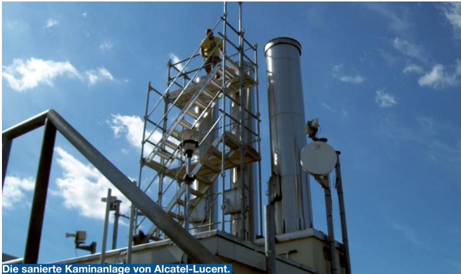
Die sanierte Kaminanlage von Alcatel-Lucent.
